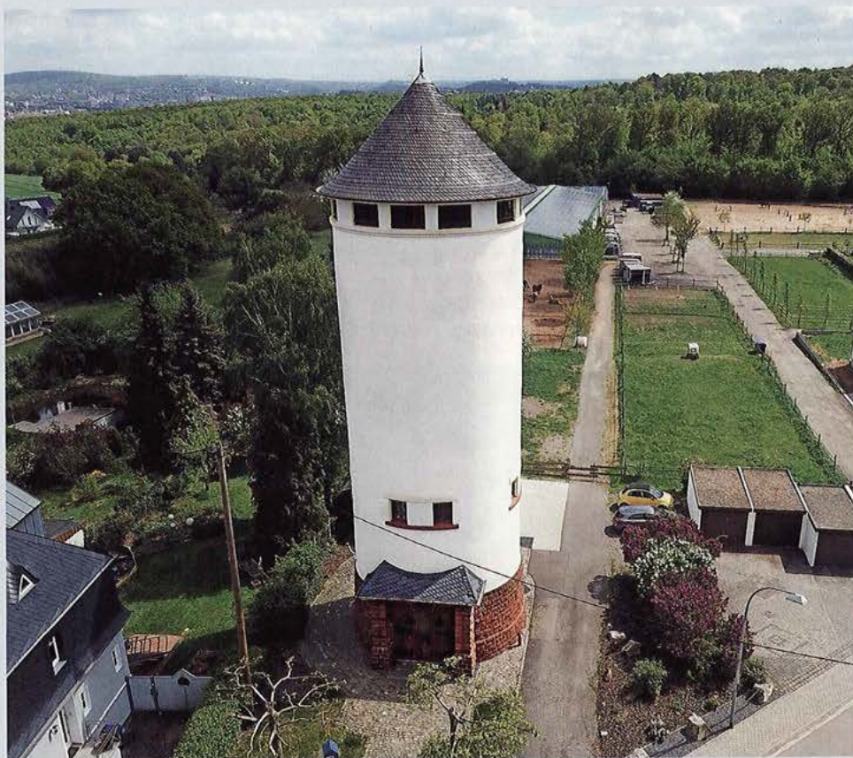
Die Schadenmanagement Gerhard GmbH hat ihr Firmendomizil im denkmalgeschützten Alten Wasserturm in Saarbrücken-Gersweiler. Fotos: Schadenmanagement Gerhard GmbH
